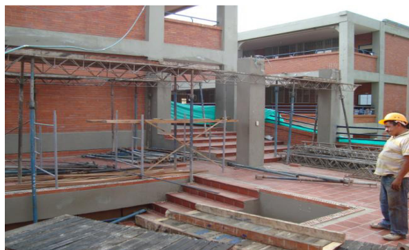
Fuente: Obra Colegio San Carlos
