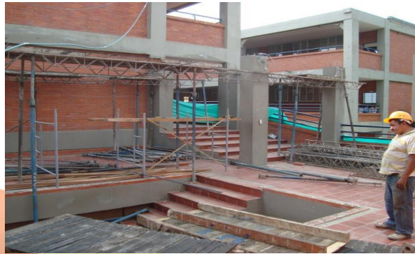
Fuente: Obra Colegio San Carlos
