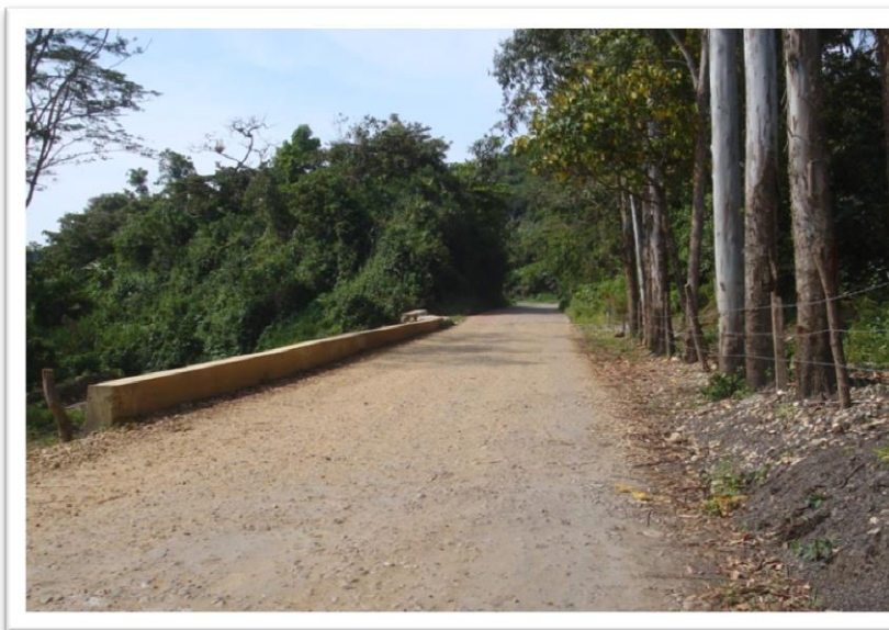
MURO EN LA VIA SUAITA-VADO REAL
