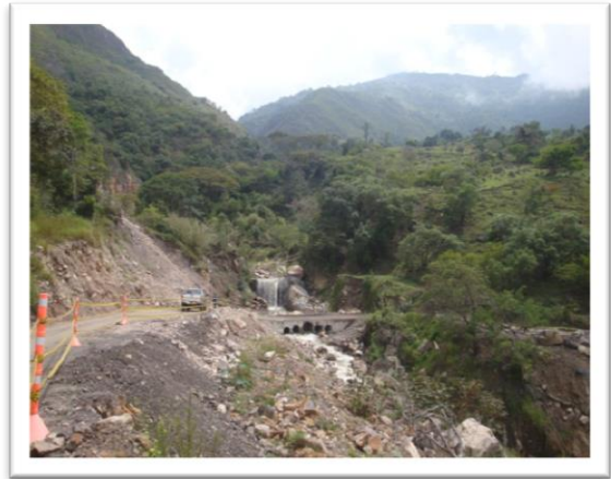
ADECUACION DEL PASO EN LA QUEBRADA LA INSULA VIA ENCISO-CARCASI
