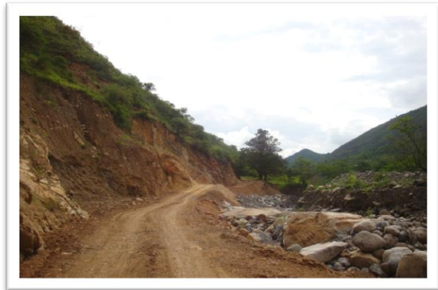
RECUPERACION DE LA BANCA VIA AGUASUCIA-SAN MIGUEL
