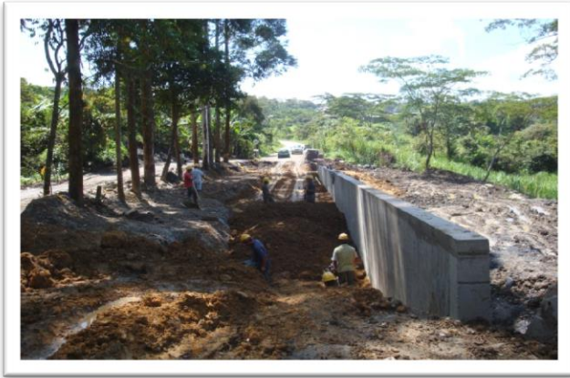
CONSTRUCCION MURO EN LA VIA SUAITA-VADOREAL
