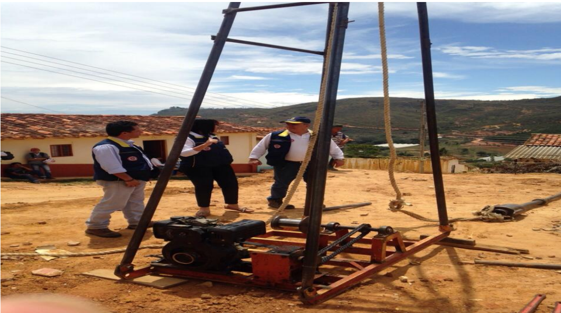
VISITA DE INSPECCIÓN A TERRENOS PARA CONSTRUCCIÓN DE VIVIENDAS NUEVAS (BETULIA)
