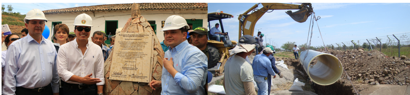
Primera Piedra Acueducto Los Santos
