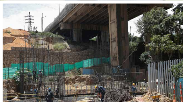
El nuevo puente La Unión toma forma.
