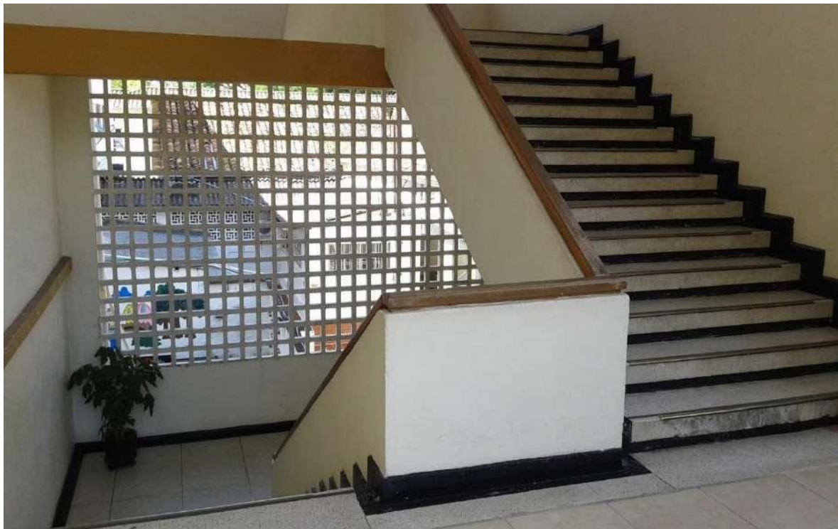
Escaleras al tercer piso – Primer tramo
