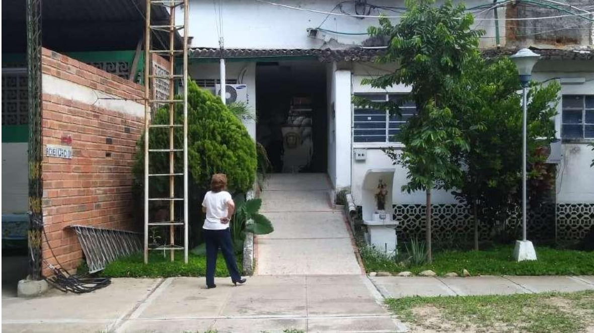
Rampa de Ingreso al área de acreditación
