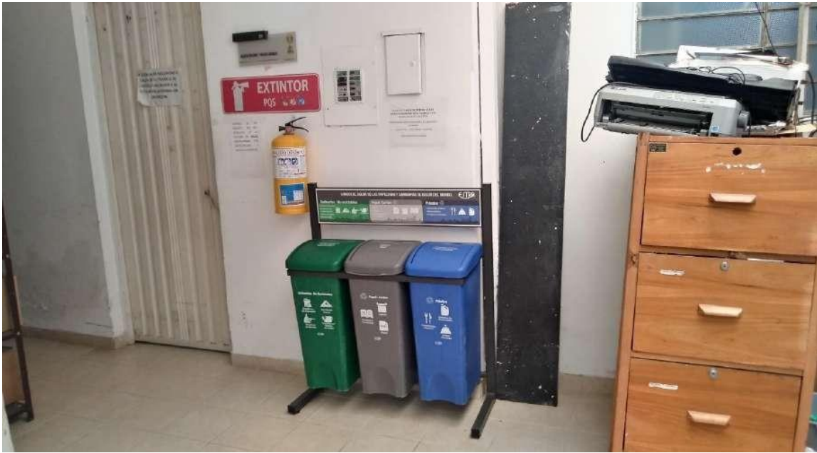
Archivos en los pasillos con daños de techos y su estructura - Acreditación
