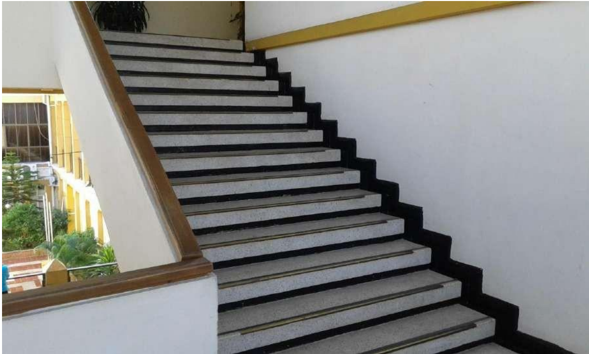
Escalera al tercer piso – Segundo tramo
