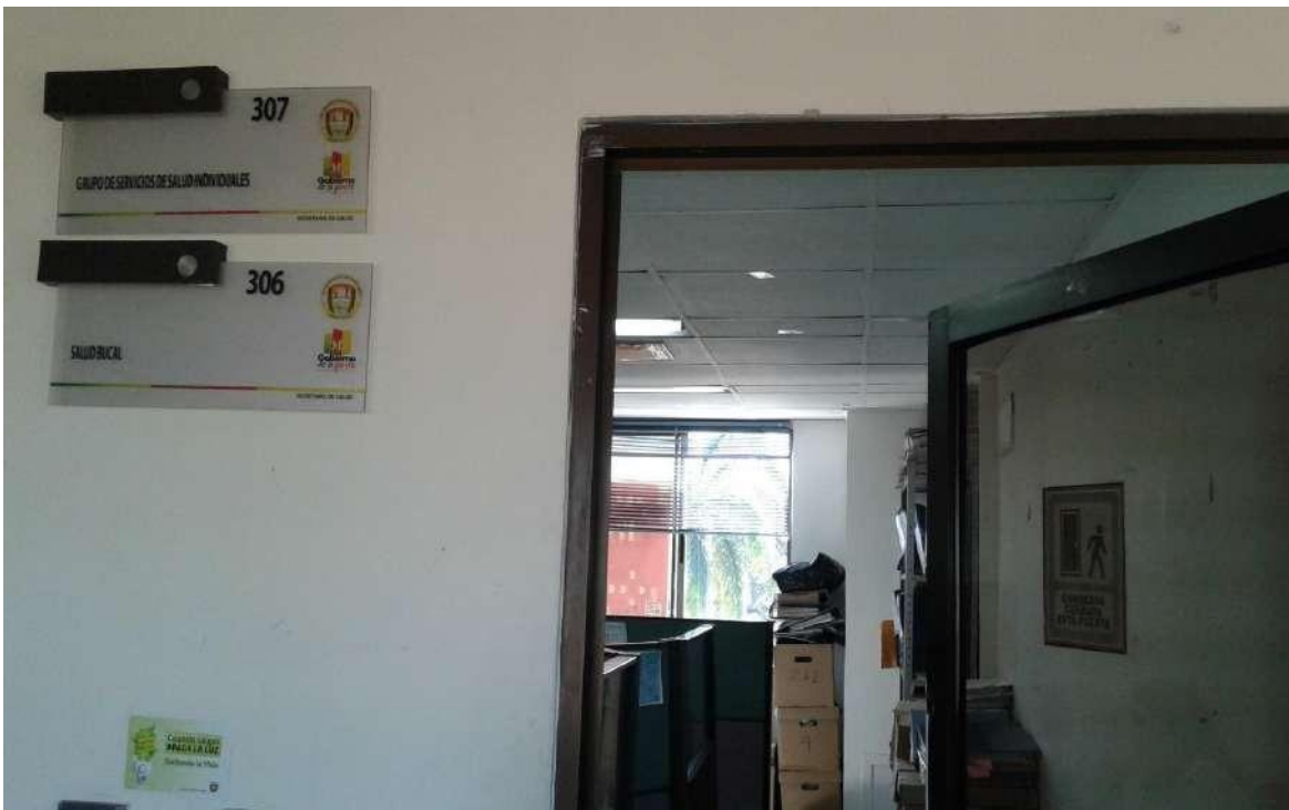
Oficinas próximas a la subestación
