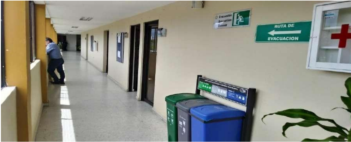
Oficinas con paso obligado por la Subestación Eléctrica.
