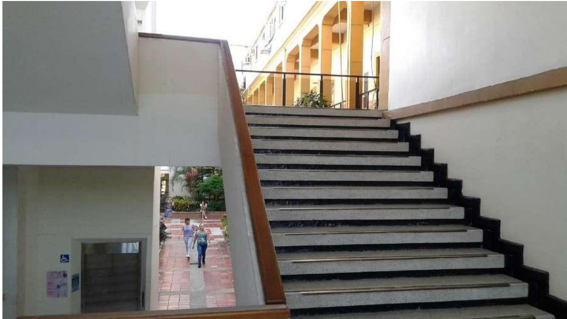
Escaleras al segundo piso – Segundo tramo.
