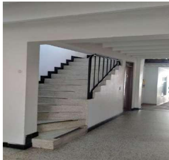
Escaleras al grupo de sistemas
