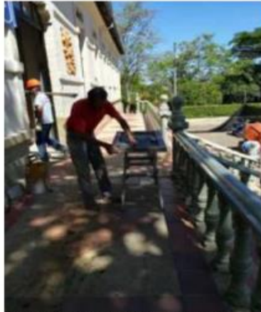
Ilustración 11. Restauración de puertas y ventanas
