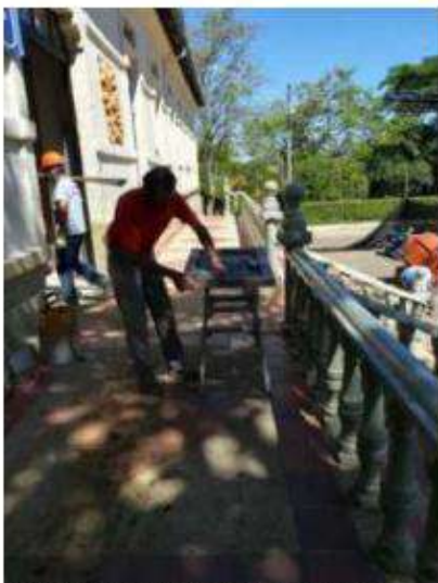
Ilustración 11. Restauración de puertas y ventanas
