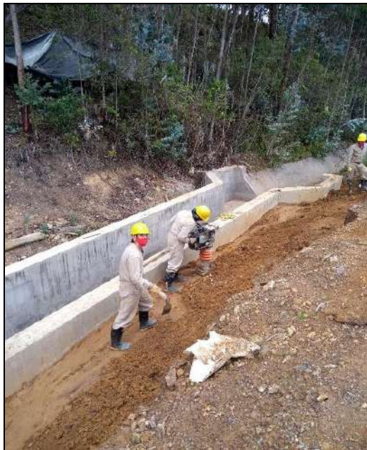
Relleno y Compactación Hombros Canal Conexión - Compactación Hombros Canal Aliviadero
