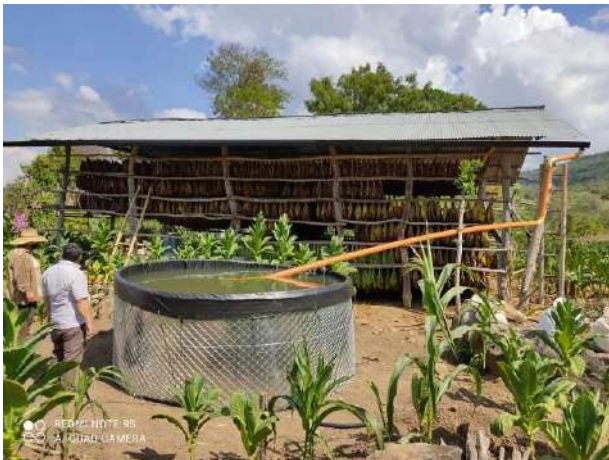
Imágenes que muestran los tanques instalados, junto con la canalización para conducir las aguas lluvias
