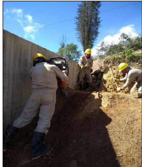
Relleno y Compactación Hombros Canal Conexión - Compactación Hombros Canal Aliviadero
