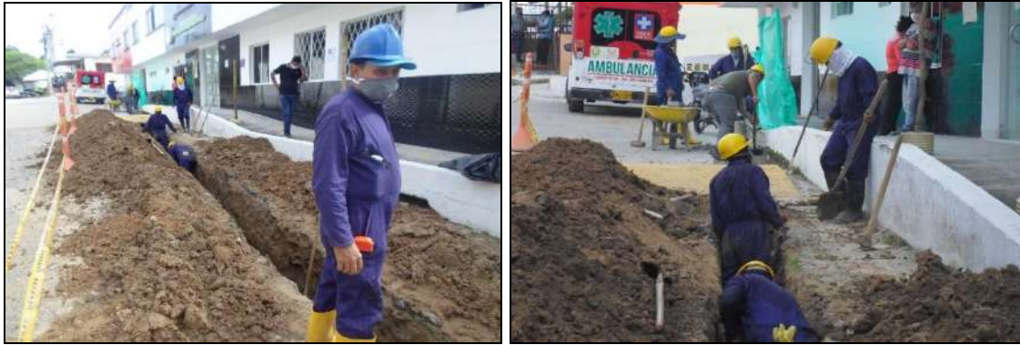
Detalles de la excavación de la zona de frente al Hospital en el barrio El Centro.
