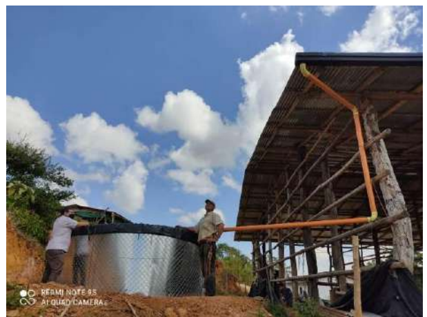
Imágenes que muestran los tanques instalados, junto con la canalización para conducir las aguas lluvias
