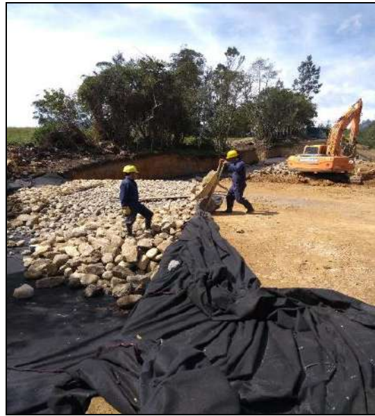
Compactación Terraza Dique 2
