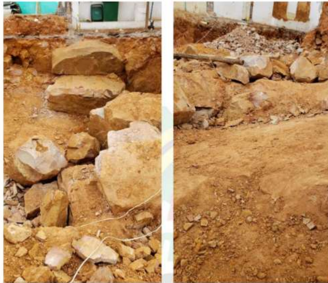
Ilustración 6. Excavación en obra
