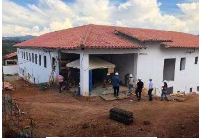
Visita de Obra Hospital Barichara
