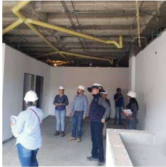
Visita de Obra Hospital Curití
