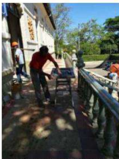
Ilustración 11. Restauración de puertas y ventanas
